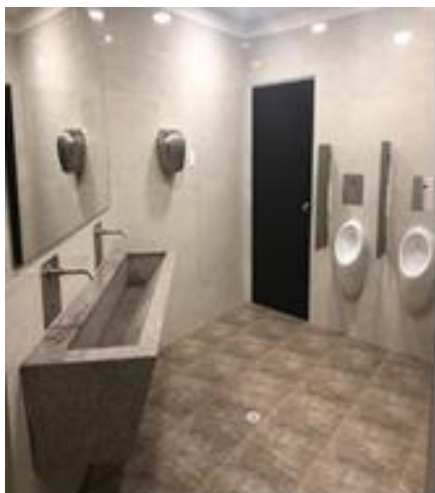
Remodelación y Modernización Baños Públicos $ 48 millones
