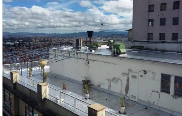
Se hace necesario la realización del mantenimiento e impermeabilización de las cubiertas que comprenden las edificaciones que se encuentran en el Hospital Militar Central por un valor de \$ 286 millones, debido al deterioro y filtraciones de aguas lluvias y con el fin de mitigar daños en las instalaciones y suspensión de los servicios de salud que brinda la entidad; la obra da cumplimiento a la Normatividad vigente **NTC 3488** con la finalidad de garantizar la conservación de las instalaciones.
