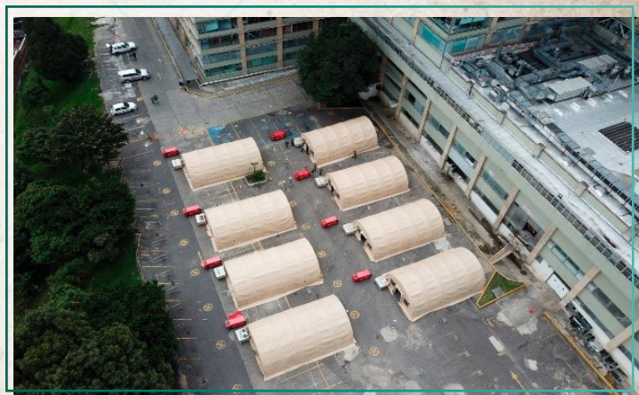
Instalación hospital de campaña para emergencia COVID-19, Hospital Militar Central Archivo CORE / HOMIL
